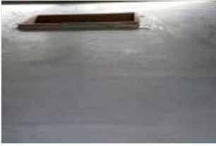
1. 바닥 단열 시공
