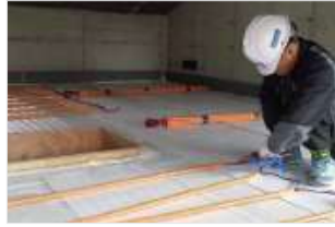
3. 전기온돌 배열 작업
