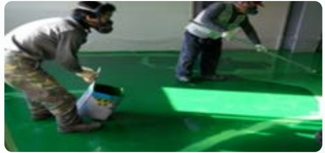
시공과정 및 시공 후 사용과정에서 휘발성 유기화합물 발생 (방독면 등 안전장치 필수)
