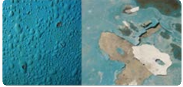
통기성이 없어 습기(기체압력)로 인해 도막이 부풀어 들뜸 및 박리, 탈락 현상 발생
