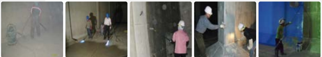
1. 건식청소 2. 배수지 내부 건조 3. 프라이머 도포 4. 바탕조정재 도포 5. 상도재 도포
