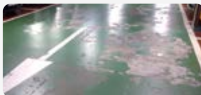
관공서 지하주차장 에폭시 마감상태
