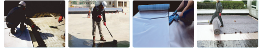
1. 바탕면 정리 2. 프라이머 도포 3. 에코 방수·방근 복합시트 부착 4. 보호덮개 시공
