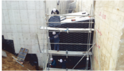
2. 터보시트 GTR3000 시공
