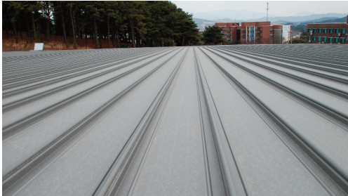
Long Span – 62m 공사
