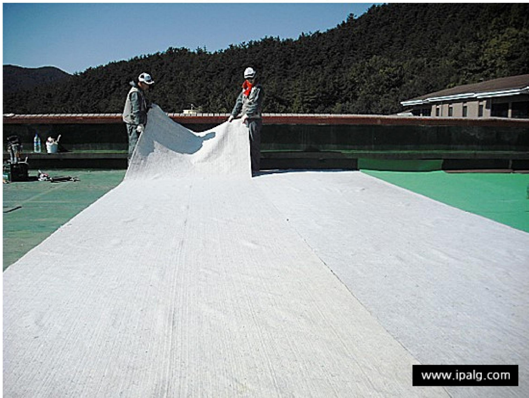
옥상방수 - 트라이슈머® 단열베이스카펫 시공
