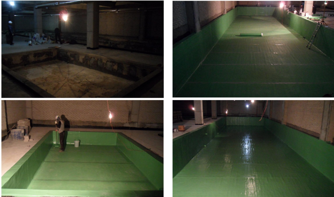
현대 아이파크 수영장방수 시공사례
