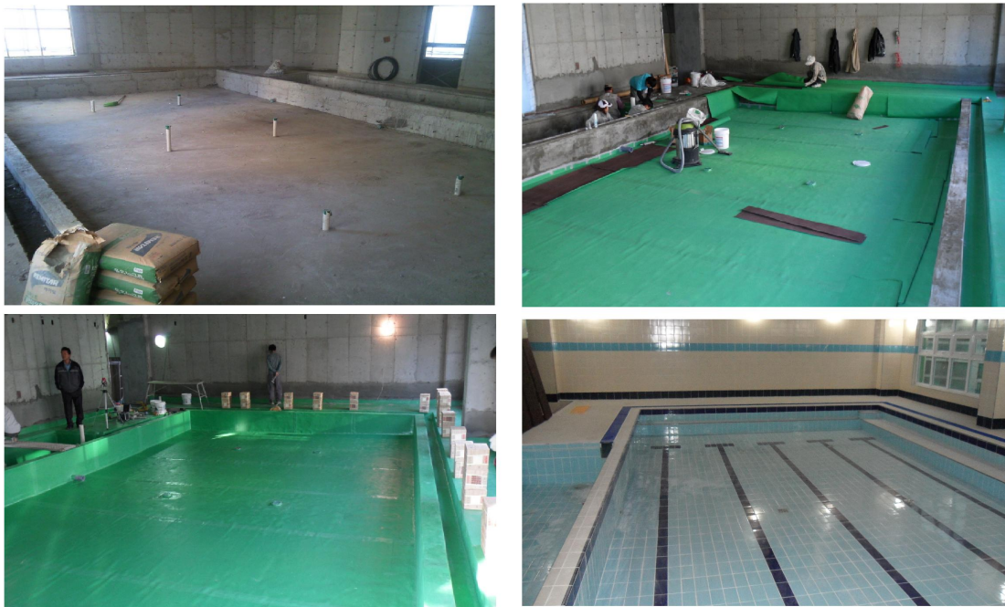
화성 한빛 유치원 수영장방수 시공사례
