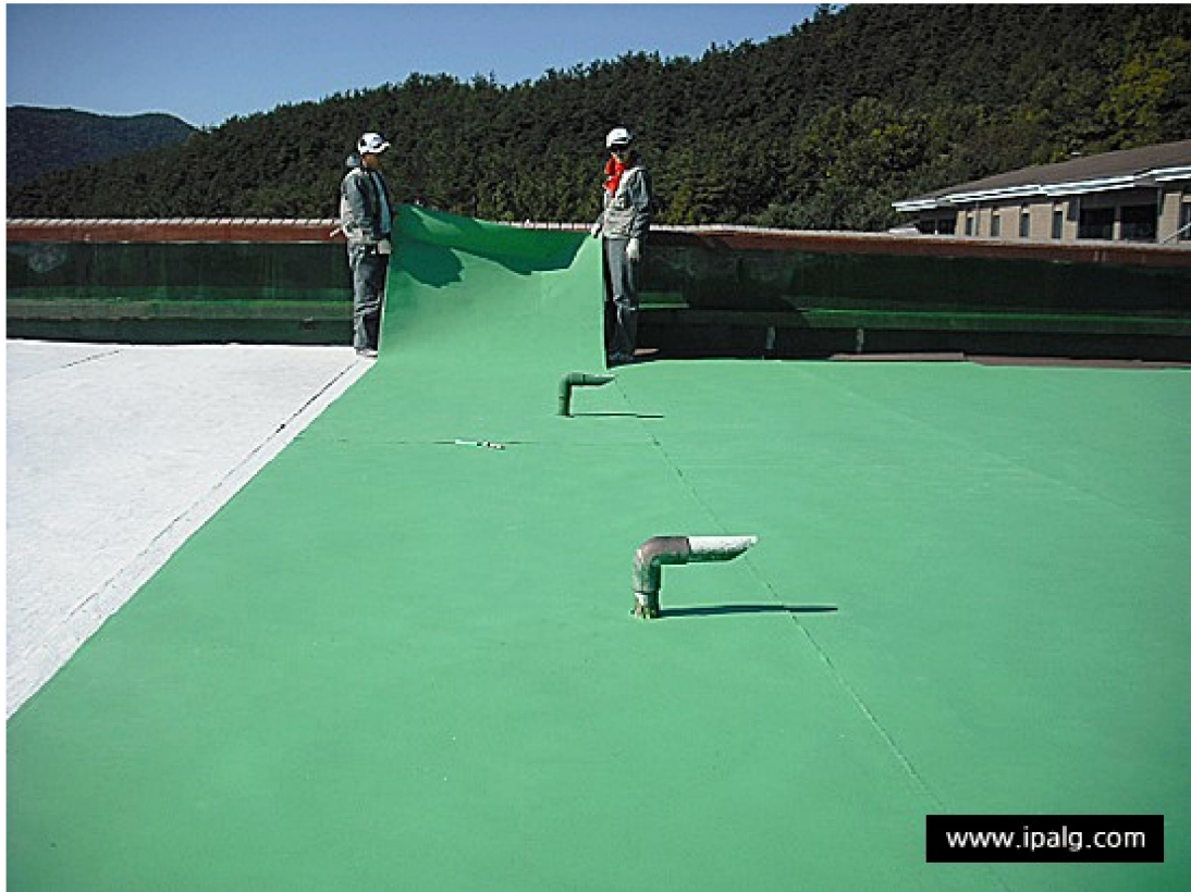
옥상방수 - 트라이슈머® 단열복합시트 시공
