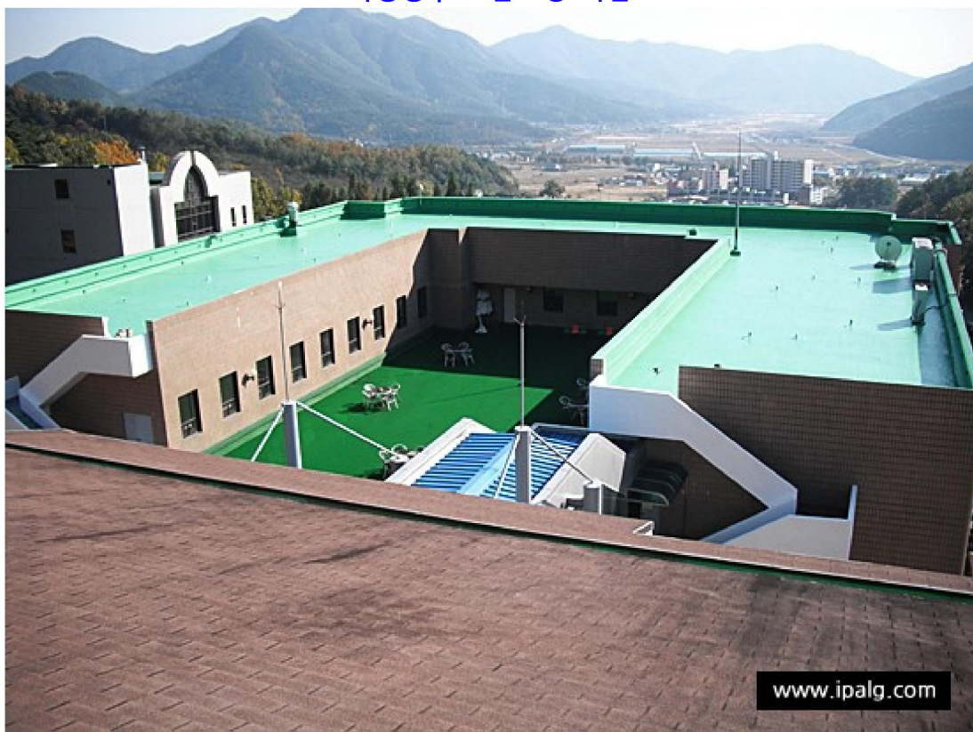
옥상방수 - 시공후 전경
