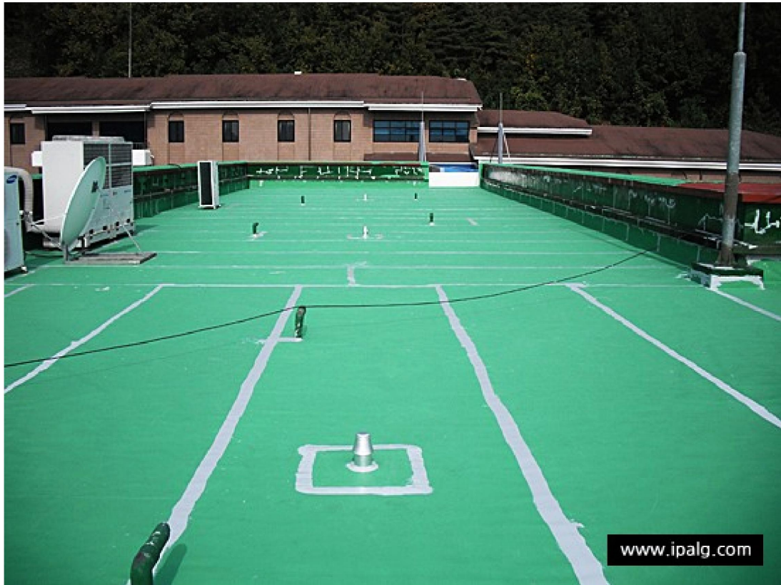
옥상방수 - 시트 이음매 접합과 코너부위 셸링 마감후
