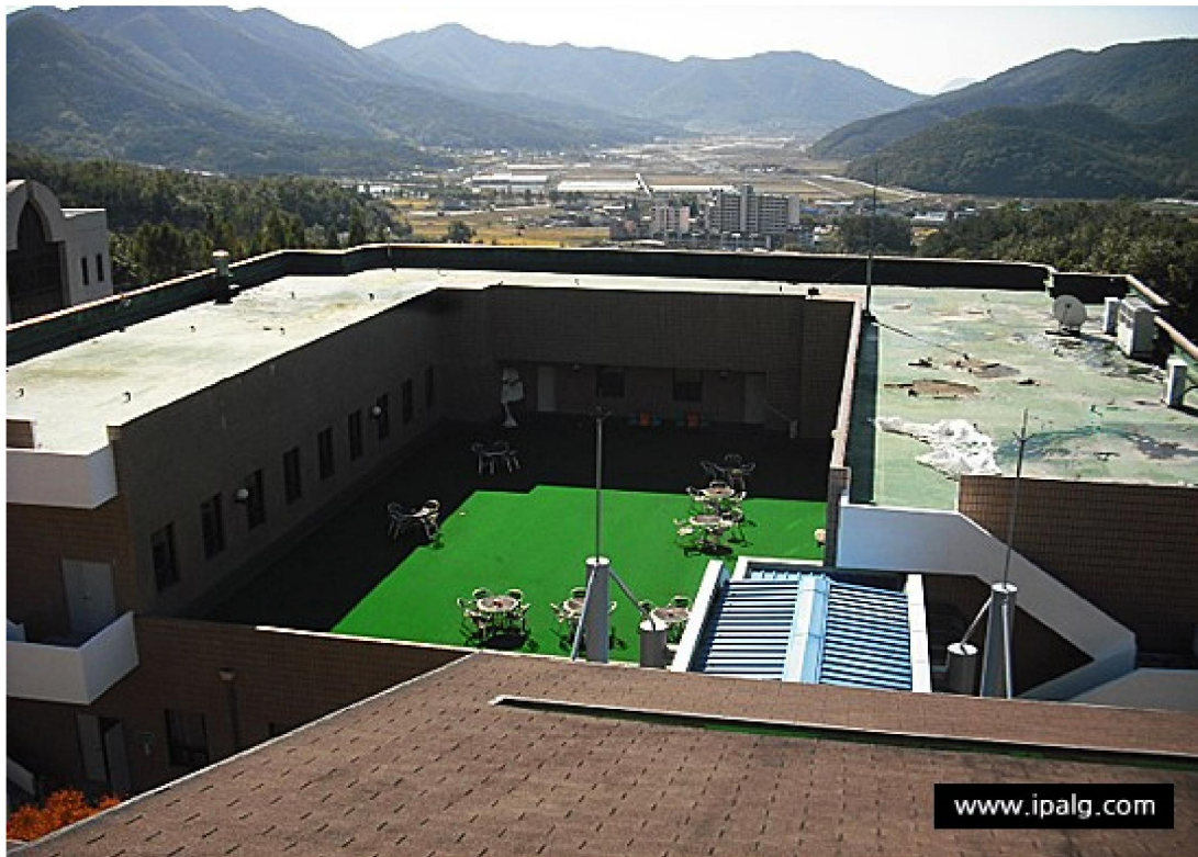
옥상방수 - 시공전 전경
