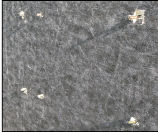
1. 단열재 고정 및 앵카볼트 삽입
