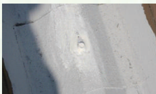
에코루프® 웨브릭을 활용한 금속지붕 취약지구 보강처리
