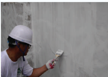
보수/보강 처리 후, MC 프라이머 도포
