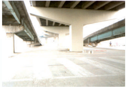
고속도로 교각 크랙(균열)보수 및 콘크리트 중성화방지
