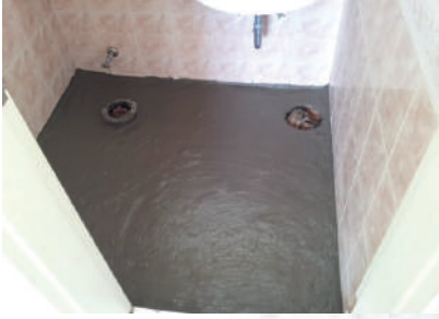
화장실, 공중목욕탕, 사우나 바닥 방수
