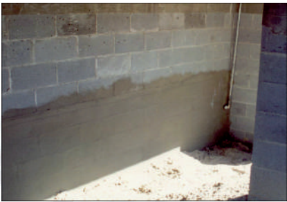
지하층 내외벽 바닥방수 저수시설의 내외벽 바닥방수
