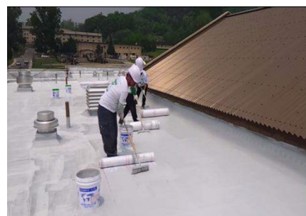
<신청기술 : 1 인 시트 1 롤 시공>
