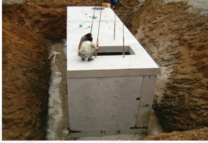
배수시설, 수영장, PC저수조
