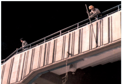
다리 및 고가 크랙(균열)보수 및 콘크리트 중성화방지
