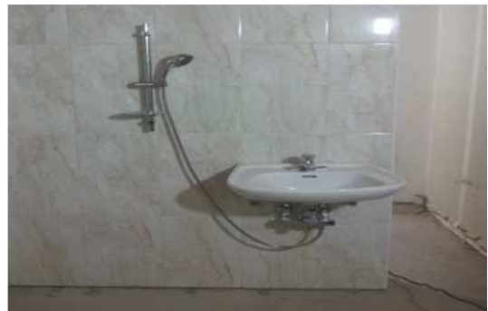
세면대 /샤워기 설치(별도보강 없음)
