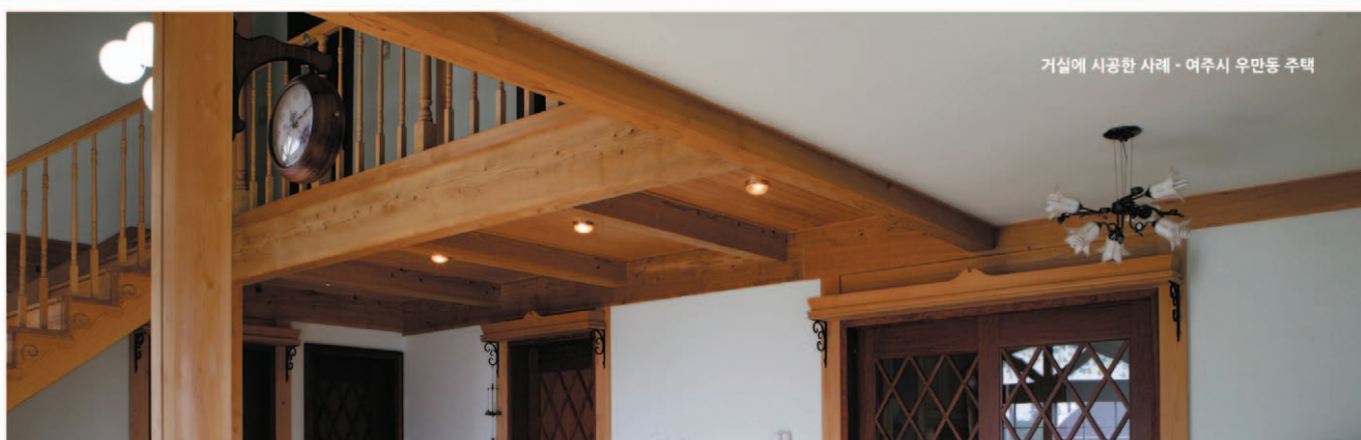
서까래 사이에 시공한 사레 - 홍성 흥동 불고기 식당
