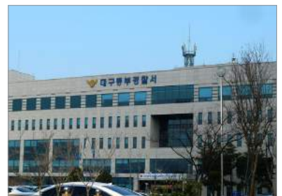
서한건설 대구 동부경찰서 신축현장
