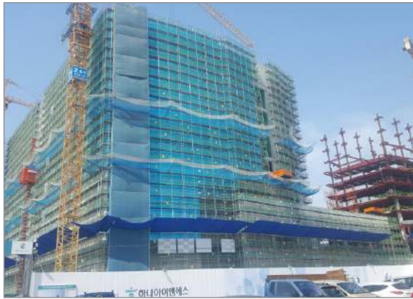
GS건설- 인천 청라지구 하나금융그룹통합데이터 센터 현장(준불연 로이단열재 시공)
