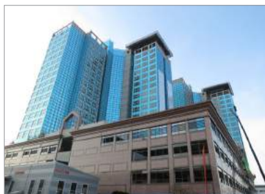
유호건설 유호N-CITY 주상복합 현장
