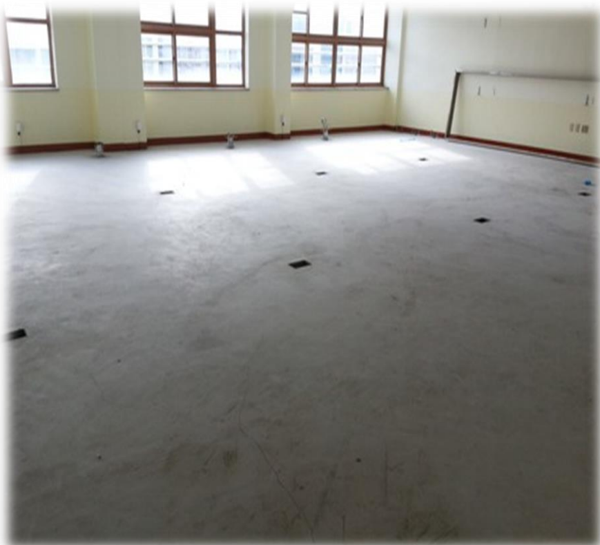
신축학교 콘크리트 바닥
