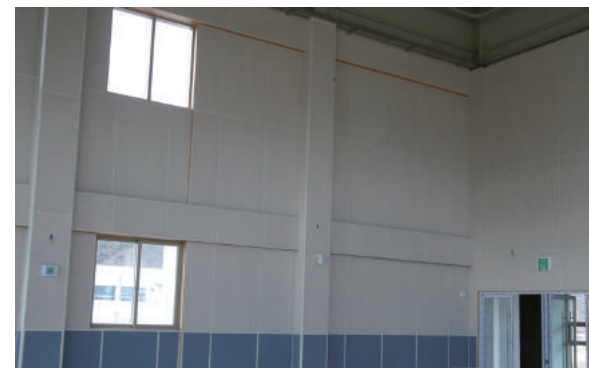
문경 산북복지회관 체육관 (ST보드 시공)
