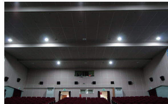
아산 시민 생활관 (ST보드 시공)
