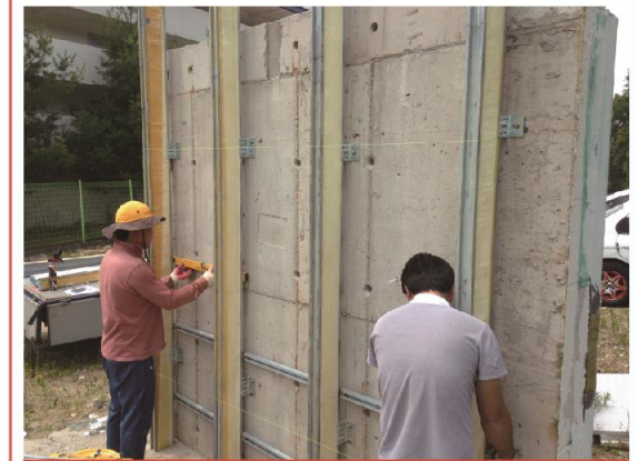
3. 프레임, 횡보강대 설치
