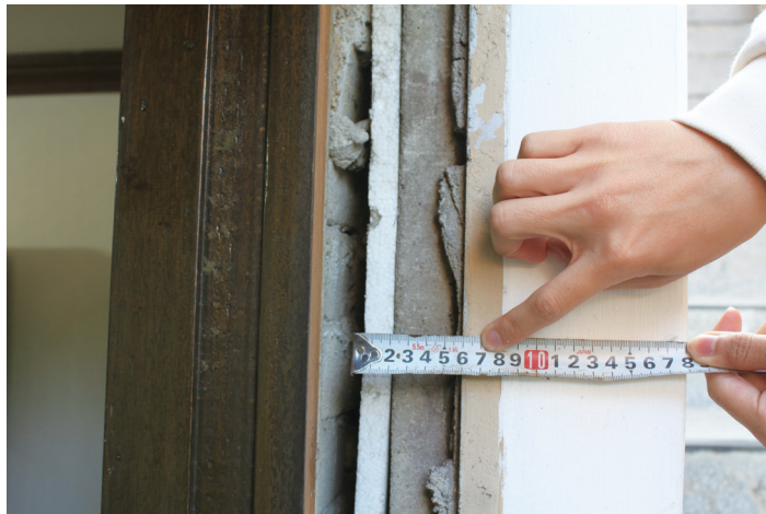
기존 주택에 설치된 1.5cm 비드법 단열재 (중단열)
